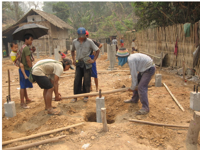
Gjenoppbyggingsarbeid i leiren © TBBC
